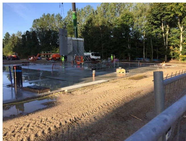
Elementerne hejses på plads til den nye fabrik
