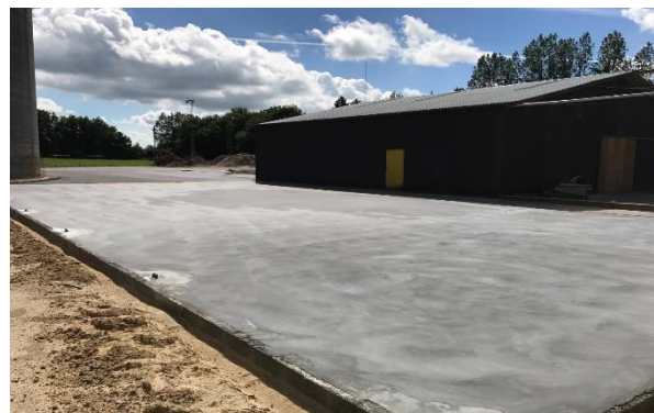
Støbning af gulv
