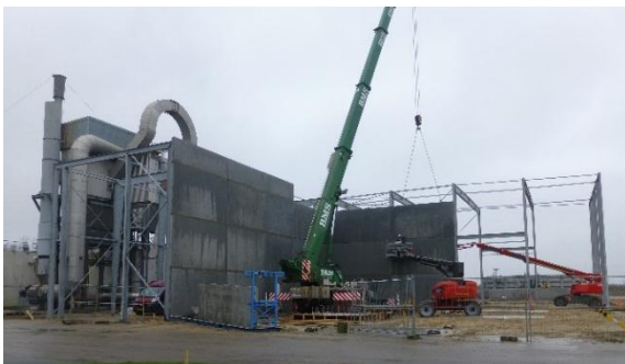
Betonmurene løftes på plads
